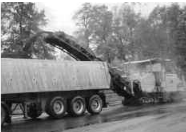
1996 - Abfräsen der Teerdecke
