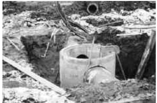
1996 - Einbau der Wasserzisterne zur Wasserversorgung der Plätze
